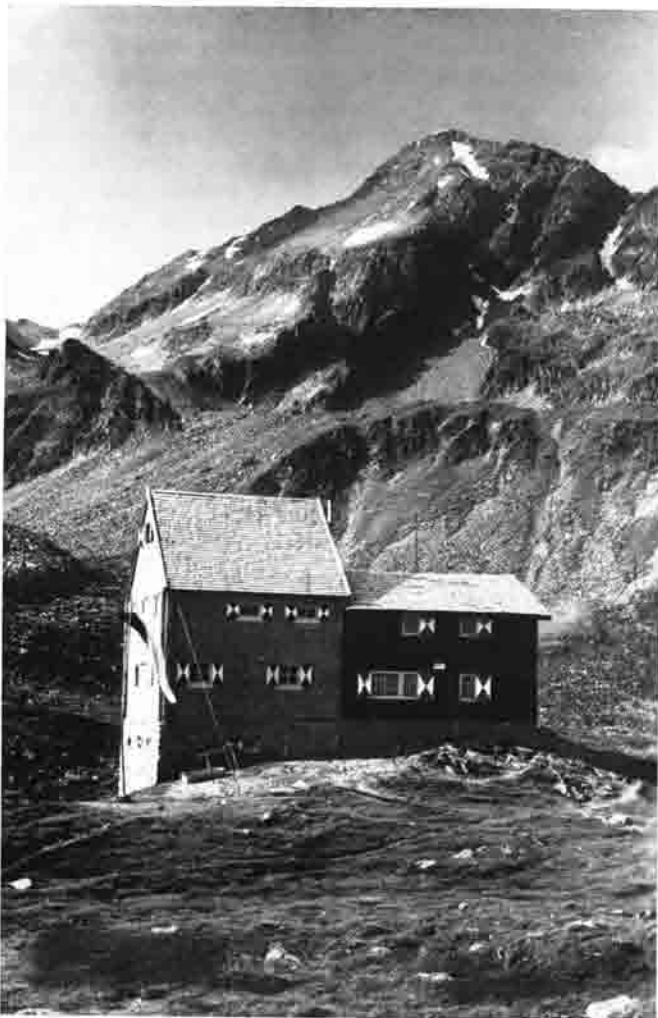
Hochschoberhütte und Hochschober (3240 m)
