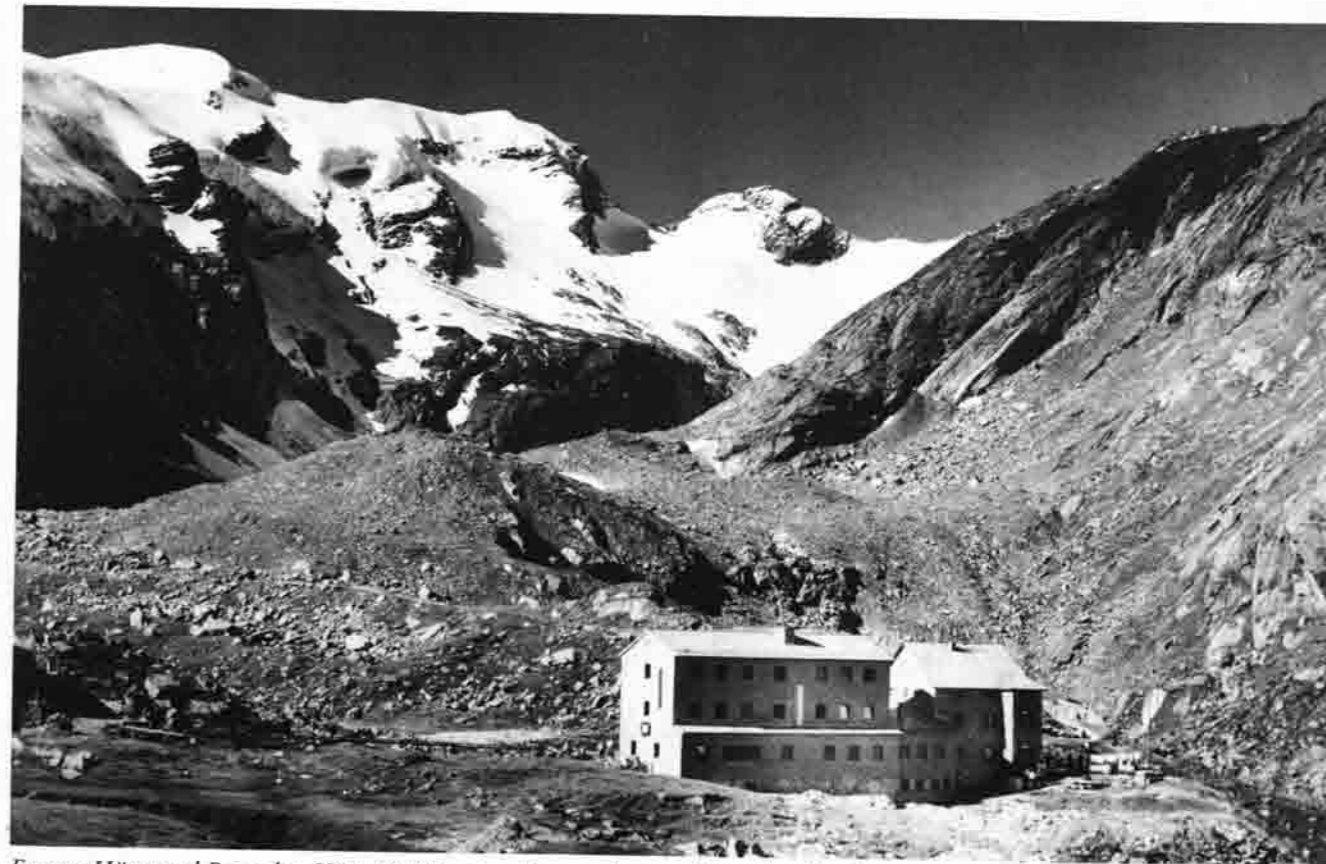
Essener Hütte und Rostocker Hütte (2 208 m) im Maurertal gegen Maurerkeesköpfe.
