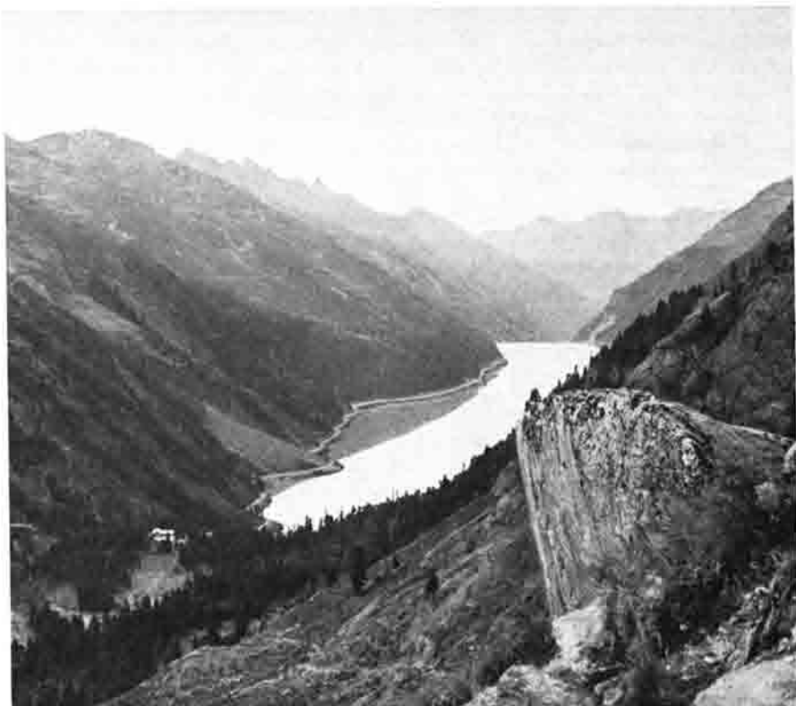
Wenn man nach anstrengender Bergfahrt von den Höhen herabsteigt, sieht man das Gepatschhaus im Zirbelwald liegen und den 1965 beim Bau des Kautal-Kraftwerkes entstandenen Stausee.
