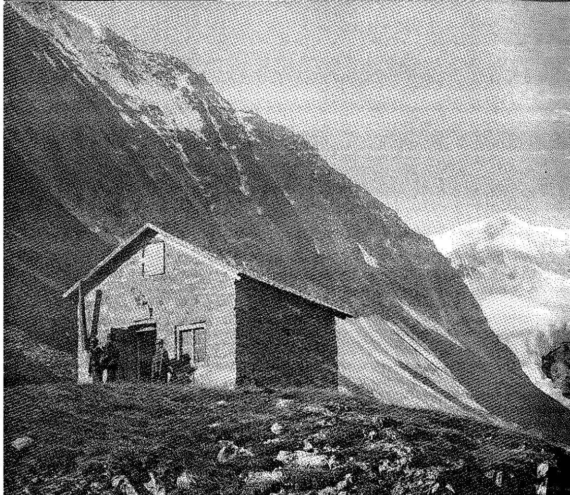
Die alte Taschachhütte, 2433 m, erbaut 1874, heute Winterraum.
