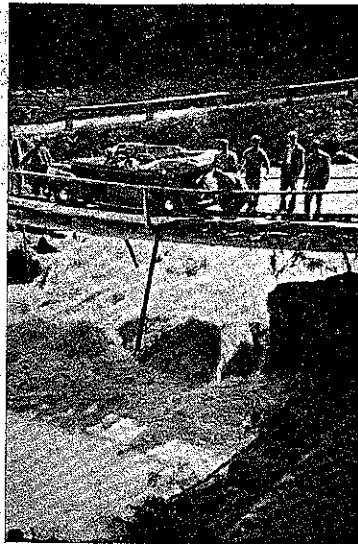
Die untere Notbrücke mit Verstärkungen während des Abtransportes. (Aufnahme: Dr. Willi Schönhuber.)
