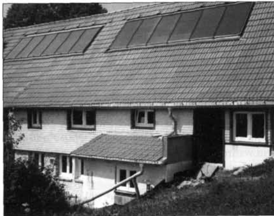
Mittlerer Teil mit Sonnenkollektoren Foto: Kai Lebrecht
