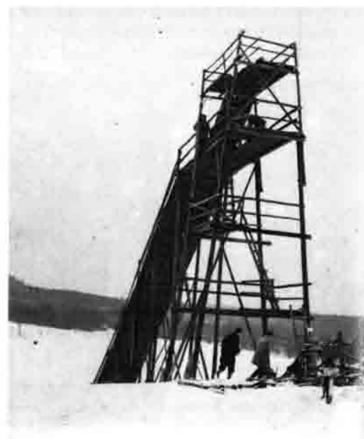
Der zweite, verbesserte Anlaufurm ist fertig
