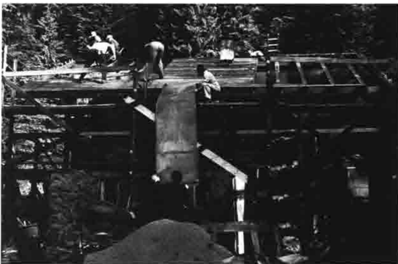
Bei der Bauarbeit, altes Dach herunter und neues Dach hinauf, mußte zügig gearbeitet werden. – Immer wieder mit dem Blick zum Himmel: „Hoits Weda oder woachts uns ei.“ 17./18./19. 6. 83.
