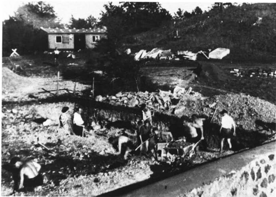
Persönlicher Einsatz und Engagement waren gefragt, als die Baugrube der Enzianhütte ausgeschachtet wurde.
