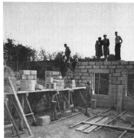
Foto: G.M. 2. Bauabschnitt
