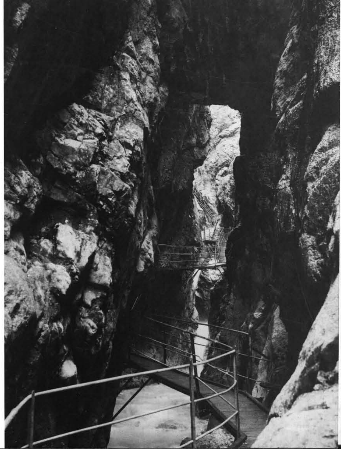
Der erste Weg in der „Engen Klamm“ unter dem großen Klemmblock (rechts oben befindet sich heute das Kreuz). Der Weg wechselte damals auf die östliche Klammseite, während er jetzt auf der westlichen Seite bleibt. Die Aufnahme entstand noch in der Bauzeit, da im Hintergrund die provisorischen Stege zu erkennen sind.
