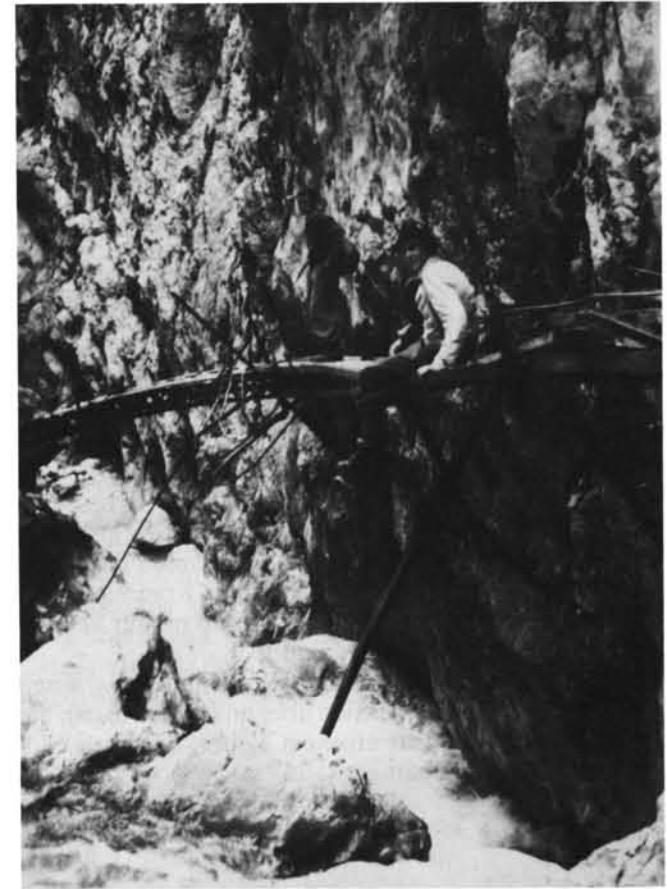
Die Zerstörungen in der Klamm waren unbeschreiblich. Auf dem Bild die schwer beschädigte Bogenbrücke und die Wandgalerie ohne Geländer und Sicherungsseile.
