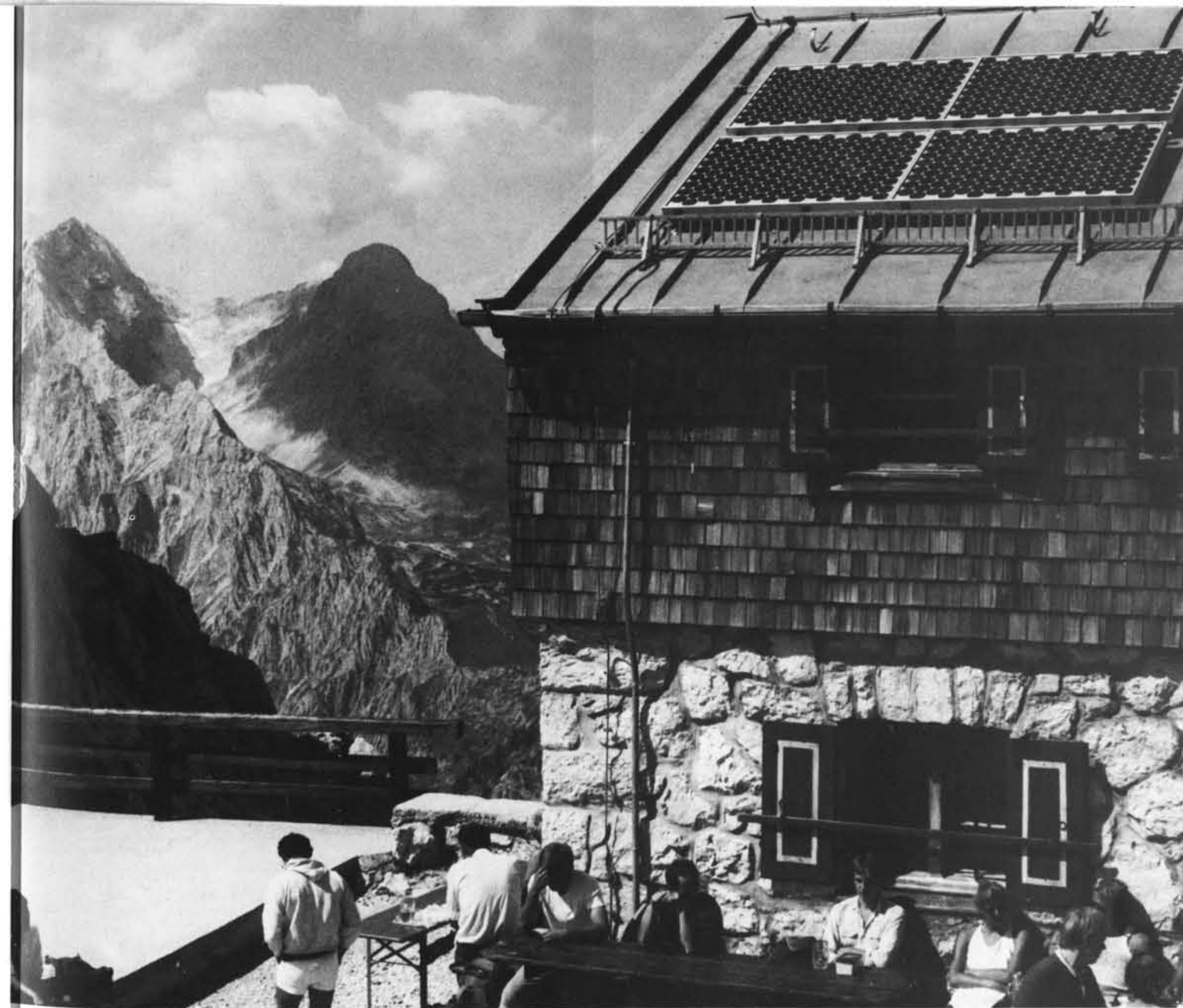
Im Gegensatz zum Windflügel gelang mit den lautlosen Solargeneratoren eine kleine Elektrifizierung unserer Meilerhütte. Die großflächigen Schaufeln hatten den Winterstürmen nicht standhalten können. Die Elemente hatten das (auch nicht gerade anschauliche) Machwerk beseitigt. Heute werden mit den 6 qm Solarpaneelen 35 Leuchten, Küchengeräte und Werkzeuge betrieben. Oben: Hütte mit den Solarflächen; hinten Hochblassen und Alp Spitze.
