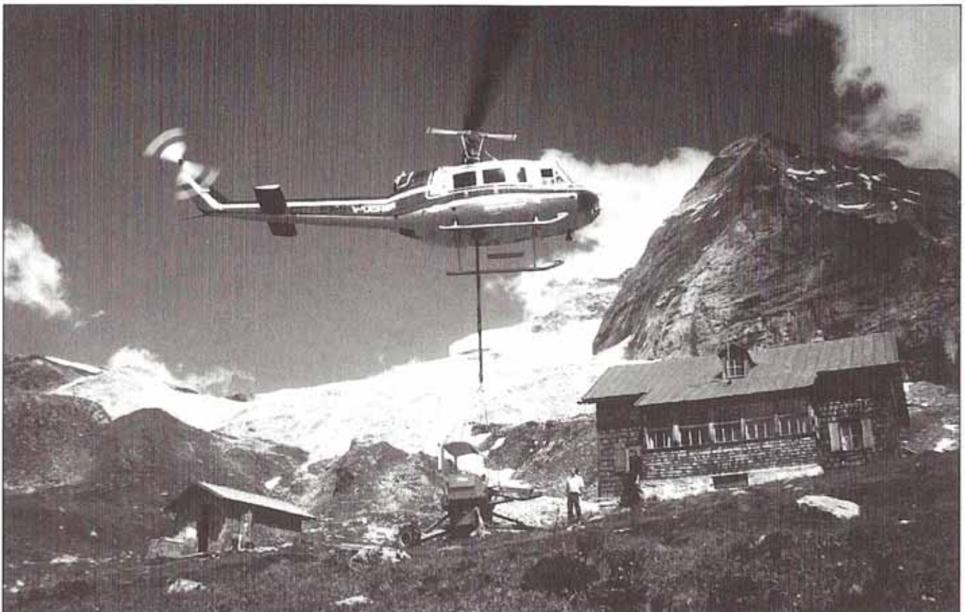
Hubschraubereinsatz an der Geraer Hütte. Das bedeutet meist Bergnot oder Abstürze mit schweren Verletzungen. Im Juli 1987 wurde jedoch das gesamte Baumaterial, die schweren Klärkammern und sogar, wie auf dem Foto zu sehen, ein in Einzelteile zerlegter Bagger zur Errichtung der neuen Kläranlage, auf die Hütte geflogen.
