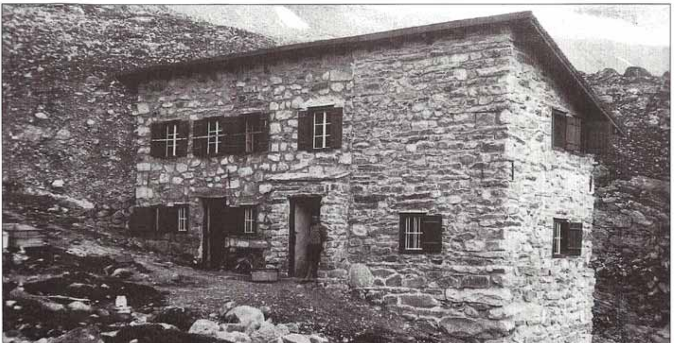
Das vergrößerte Winterhaus an der Geraer Hütte im Jahre 1927. In den neu geschaffenen Räumen sind insgesamt 12 Matratzenlager für Winterbesucher bzw. als Reservelager für den Sommerbetrieb hinzugekommen. Der berühmte Tiroler Baumeister Hofrat Dr. Ing. Sehrig konnte sich mit dem Winterhausausbau nur ein bescheidenes Denkmal an der Geraer Hütte setzen. Zum großen Projekt der Erweiterung des Haupthauses kam es erst 1932 – ohne ihn.
