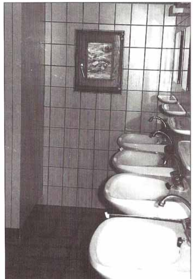
Der Sanitärtrakt im Haupthaus nach seiner Erneuerung im Jahre 1982/83
