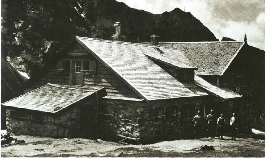
Die Geraer Hütte nach Fertigstellung des Anbaues 1934.
