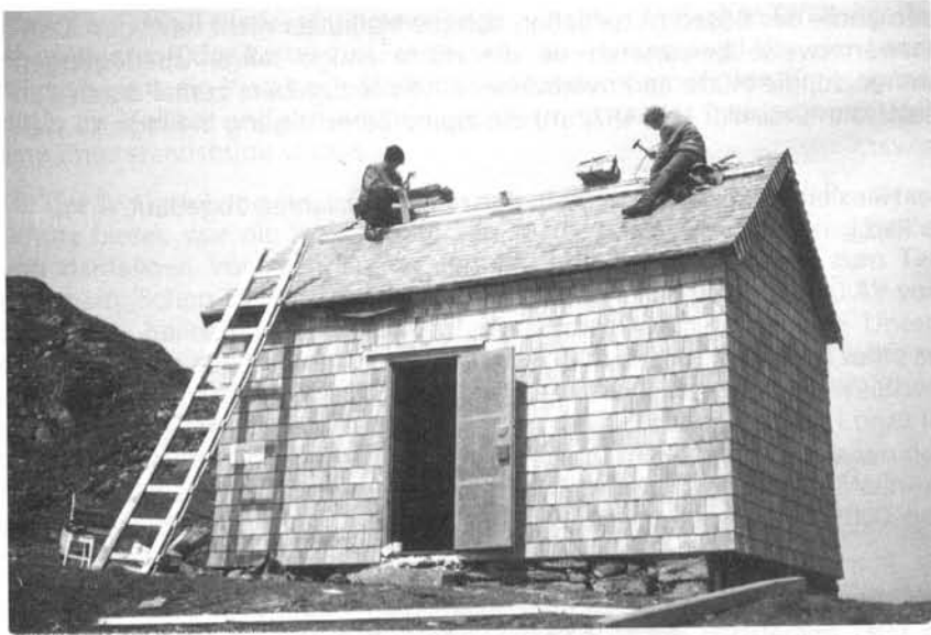
Reparaturen in schwindelnder Höhe (Foto: B. Venus, 1989)
