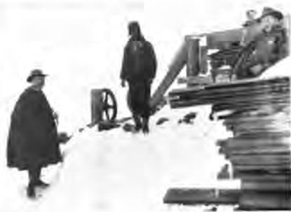
1910. Siemens. Seilbahn-Station neben dem Hüttenplatz am Monte Vioz.
