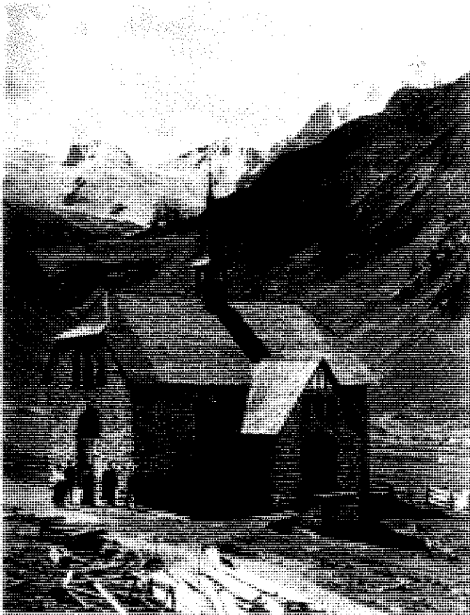
Bild 1 Blick nach Süden mit Königsspitze im Hintergrund und noch nicht aufgeräumtem Baugelände ohne Baumbepflanzung.
