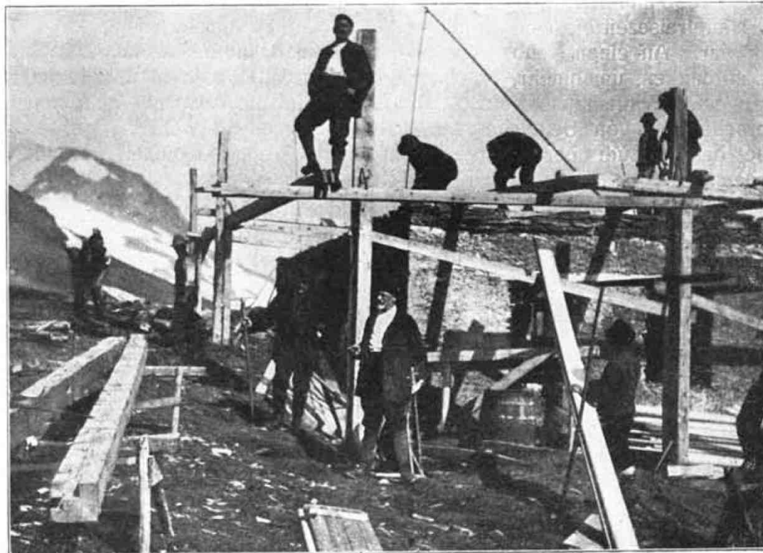
Neues Hannoverhaus im Bau, von Westen aus gesehen.
