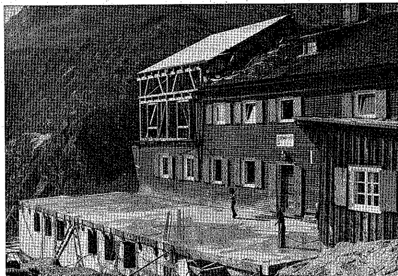
Heilbronner Hütte während des Umbaus
