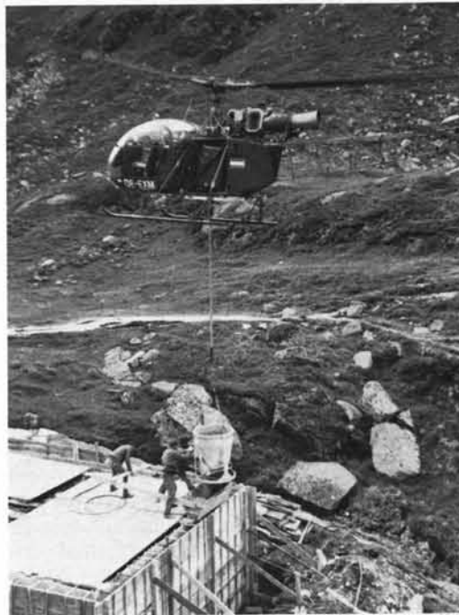
▲ Das Betonieren der Wände der Kläranlage erfolgte mittels Hubschrauber
