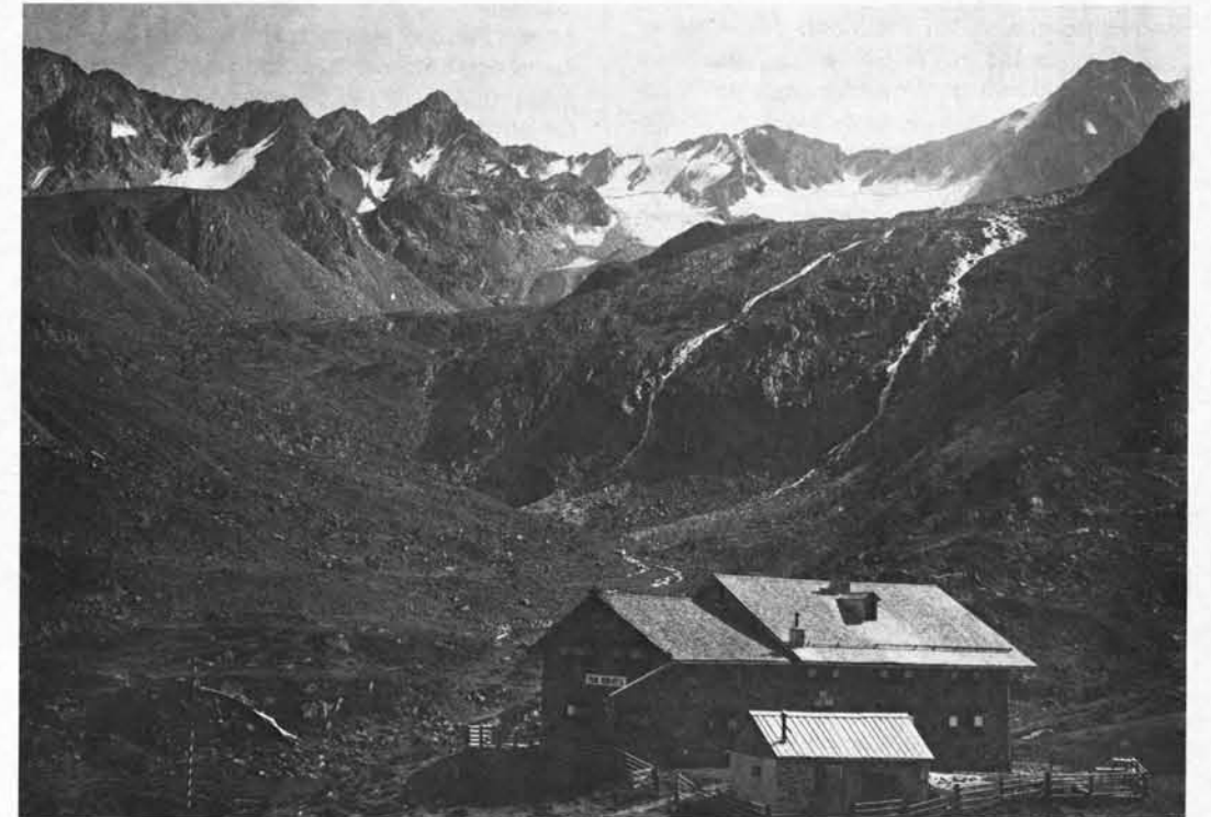
▼ Die Hütte nach dem Ausbau 1932/33
