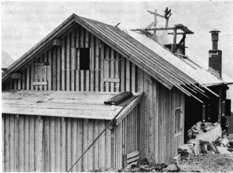
Der Anbau (Rückseite)
