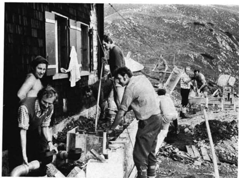
Fundament und Wasseranschluß werden errichtet
