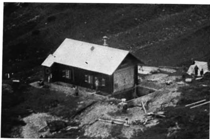
Der ausgeschachtete Keller
