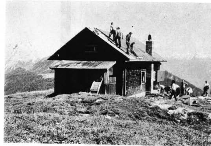
Dacherneuerung am 10./11. September 1960
