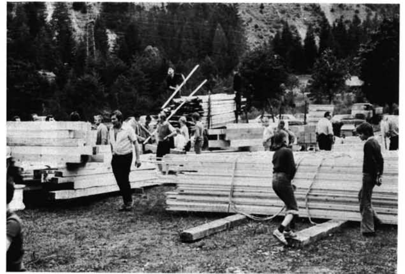
Baumaterial liegt für den Hubschrauber bereit
