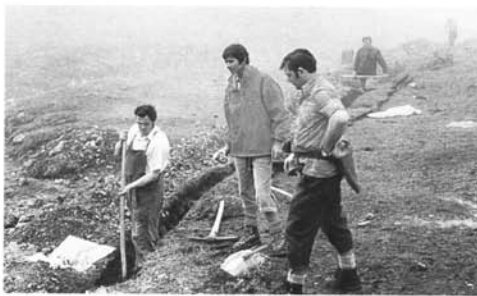
Beim Wasserleitungsbau
