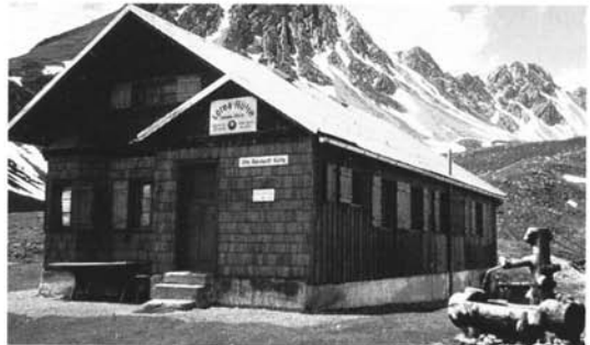
Die Hütte nach dem Anbau
