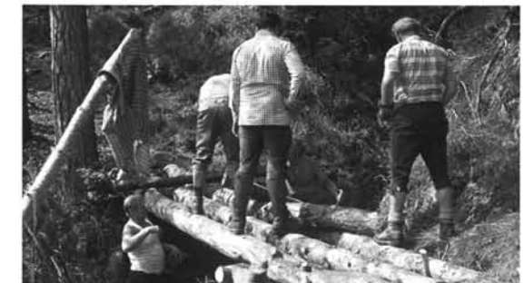
Weginstandsetzung zur Hütte
