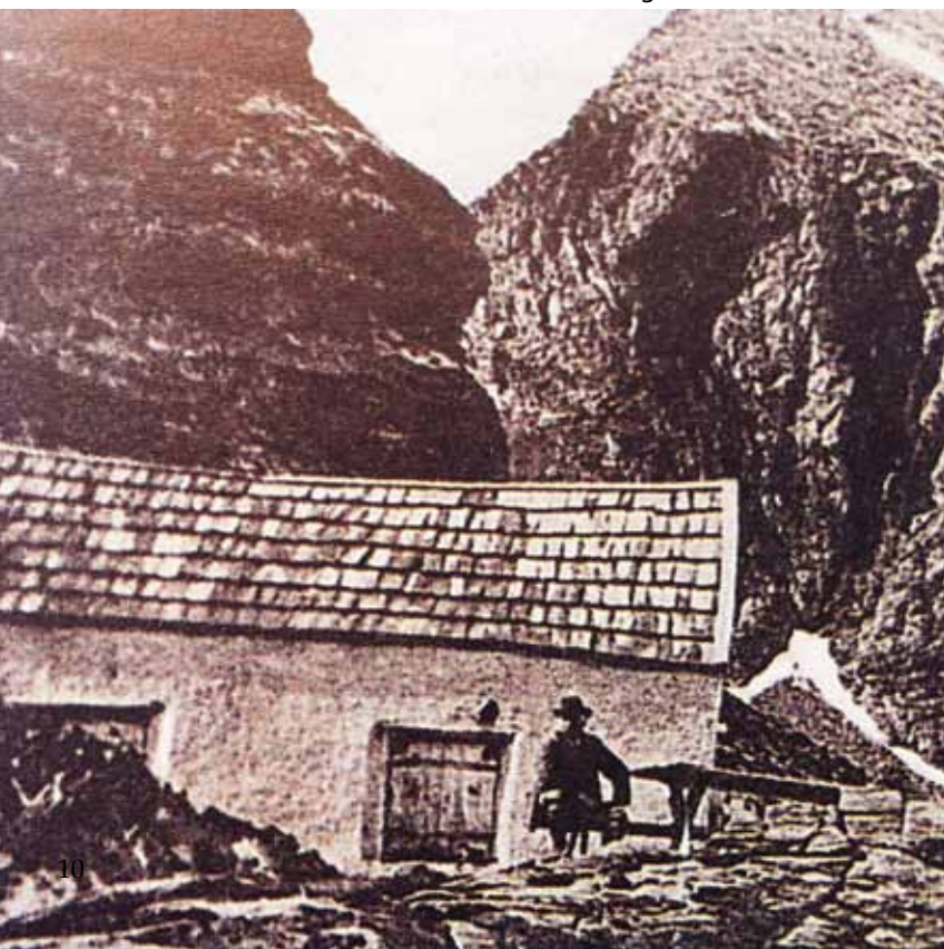
Die baufällige Rieserfernerhütte 1893
