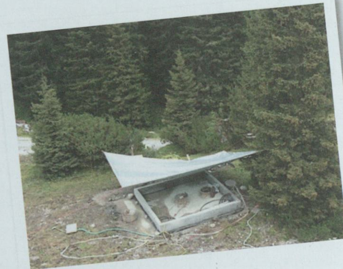
Fundament der Kläranlage
