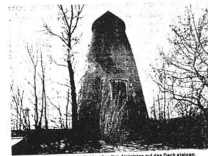
Der Spitzbunker erhält Besuch: Bald wollen ihm Alpinisten auf das Dach steigen. Bild: Mainberg
