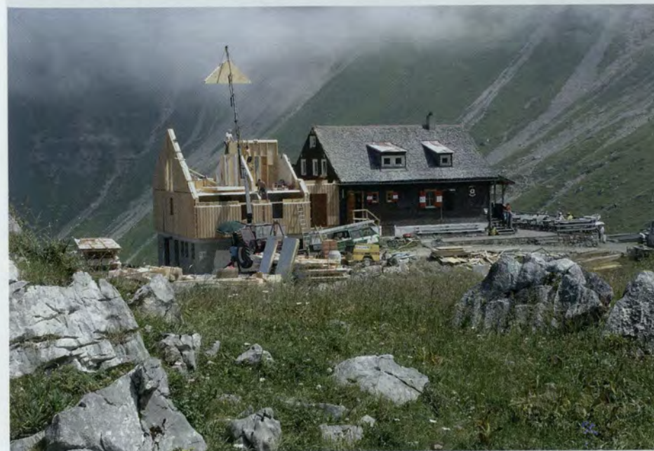
>> Einsetzen der Fertigteile (Bild Studer)
