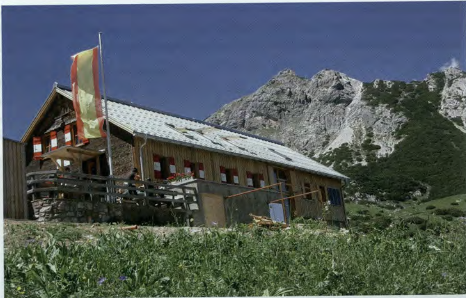
>> Oberzalimhütte nach dem Umbau
