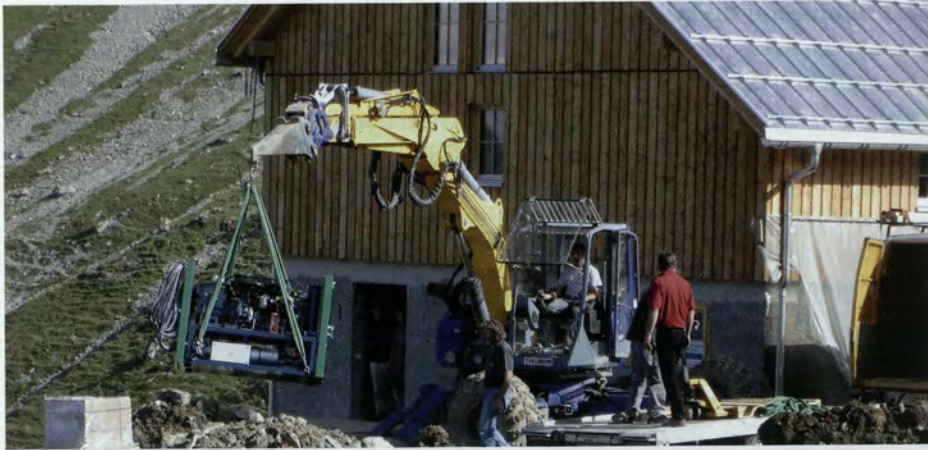
>> Anlieferung BHKW mit Wilfried Studer und Gerhard Lütkehölter (Bildquelle Hans Graze)
