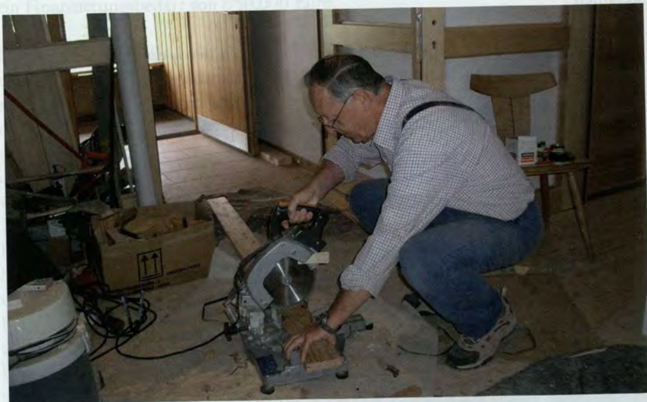
>> Der Verfasser beim Zuschneiden der Bodenbretter für die Gasträume
