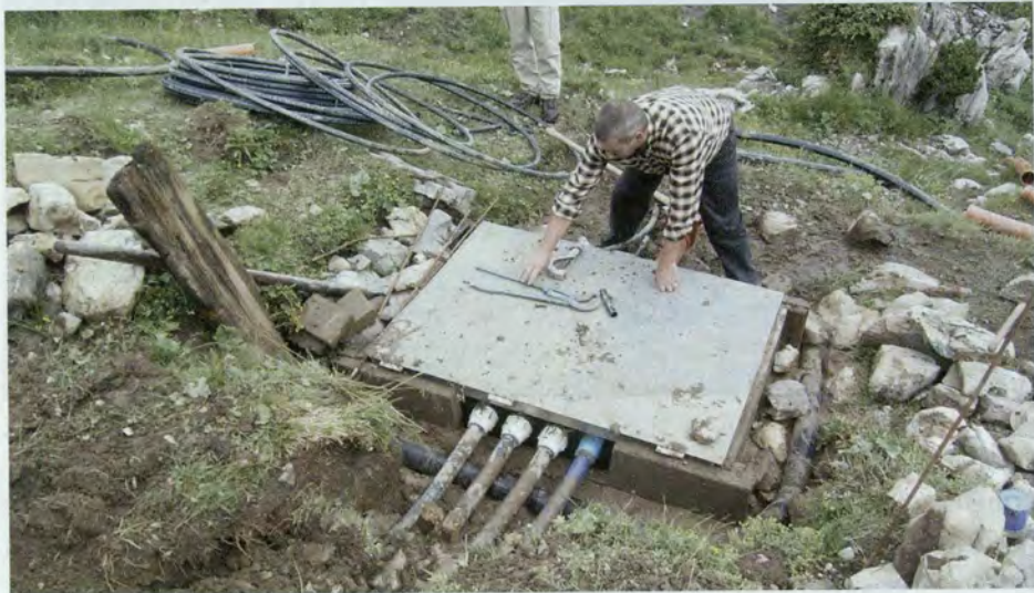
>> Sanierung Wasserfassung (Bildquelle Andrea Albold)
