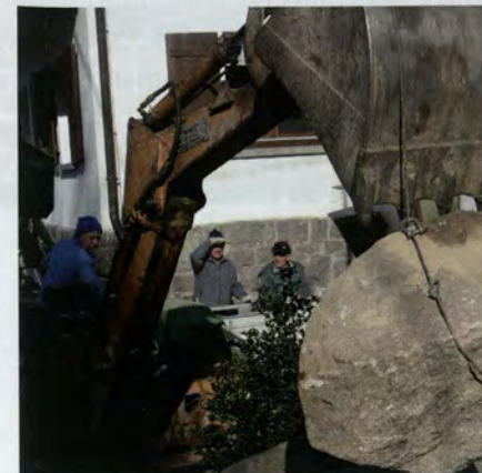
>> Nachbar Schöck hilft mit schwerem Gerät bei der Hangsicherung auf der Schönbrunner Hütte
