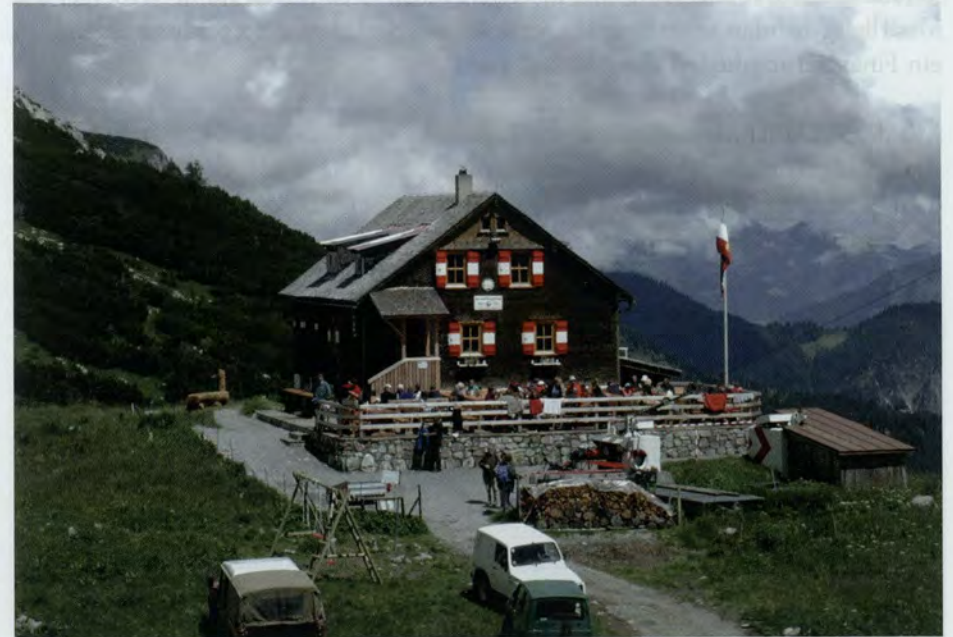
>> Die Oberzalimhütte vor dem Umbau
