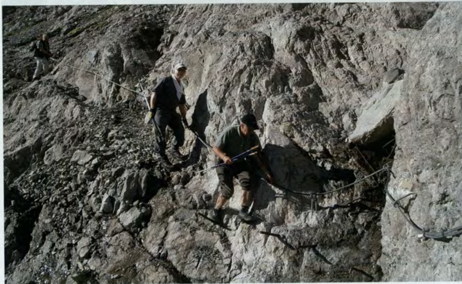
>> Seilsicherungen im Leibersteig
