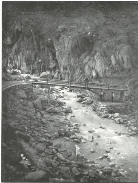
Die von der Sektion Mark Brandenburg des D. u. Oe. A.-V. im Jahre 1926 neuerbaute Brücke über die Rofen-Ache, nahe der Zwerchwand und dem „Brand“, kurz vor dem Einfluß des Vernagt-Baches in die Rofen-Ache.
