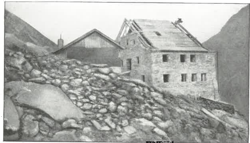
Oben und Mitte: Das „neue“ Hochjoch-Hospiz im Bau. (August 1926.) Unten: Der Neubau am Tage der Firstfeier (am 9. Oktober 1926). Neben dem Hause ist die „Baubude“ sichtbar.
