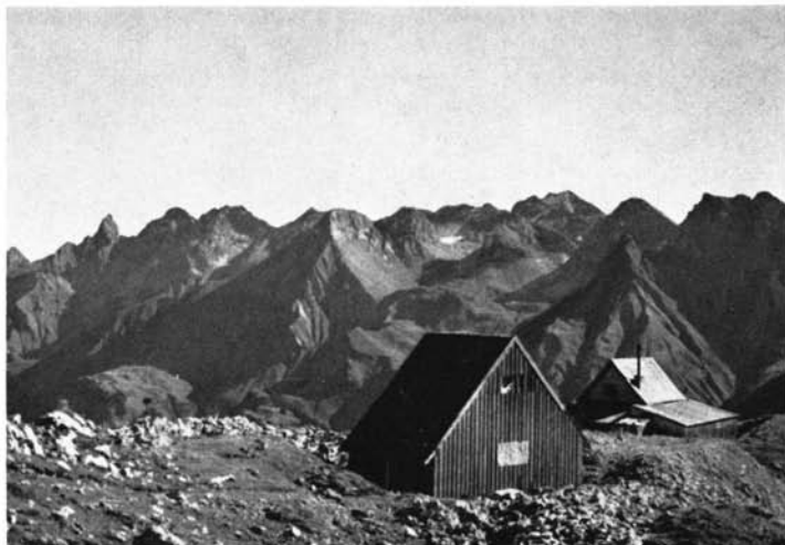
Die Nothütte – erbaut während des 2. Weltkrieges, zur Lagerung des Baumaterials
