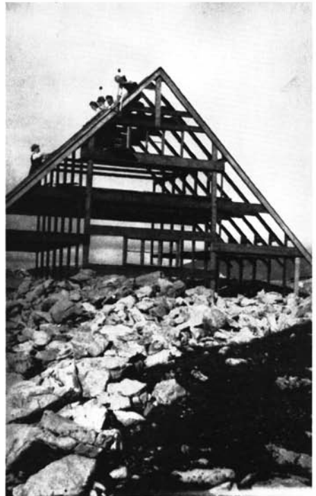
Nothüttenbau — Eiserner Dachstuhl
