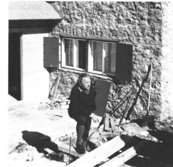
Schatzmeister Josef Landherr beim Richtfest für den Anbau 1970.
