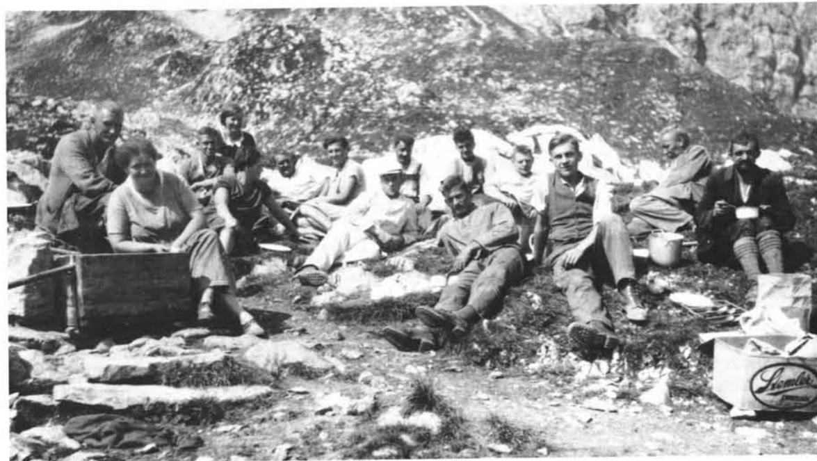
Wohlverdiente Rast beim Bau des Alpaufzuges 1927-1935; links außen Vorsitzender Franz Xaver Abt mit Frau, rechts außen Hüttenwart Hias Bebler.
