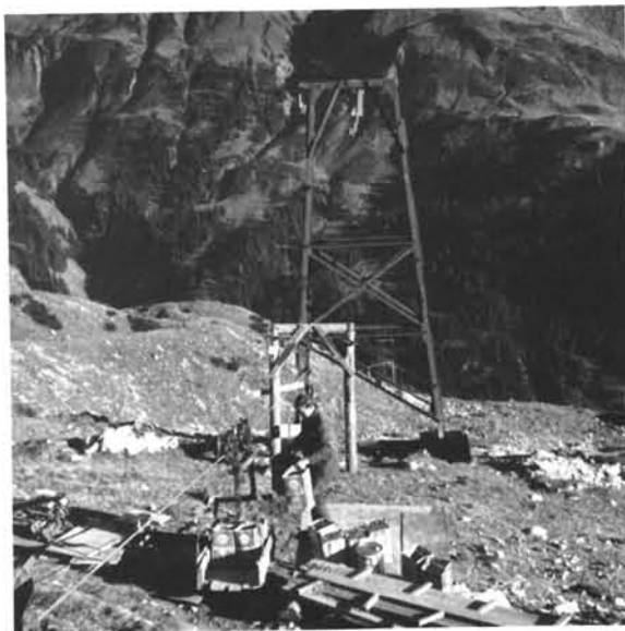
Bau der Materialseilbahn 1968.
