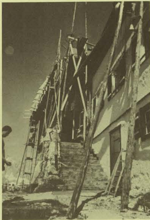
Kaum wiederzuerkennen ist das Watzmannhaus, nachdem am Eingang schwere Gerüststangen aufgestellt wurden. Eine notwendige Maßnahme zur Erneuerung des schadhaften Daches
