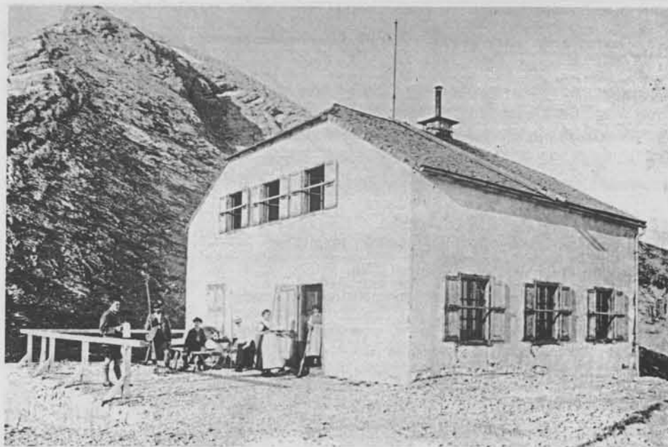
nach der Fertigstellung.
