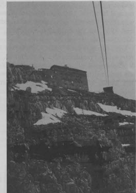
Die Materialbahn mit ihren 1000fach gespleißten Seilen überwindet von unterhalb des Mitterkaser bis zum Haus 600 Höhenmeter. Die Ladekapazität beträgt 200 kg bei einer Seillänge von ca. 2,5 km. 1987 mußte das Seil wegen Überdehnung um 12 m gekürzt werden.
