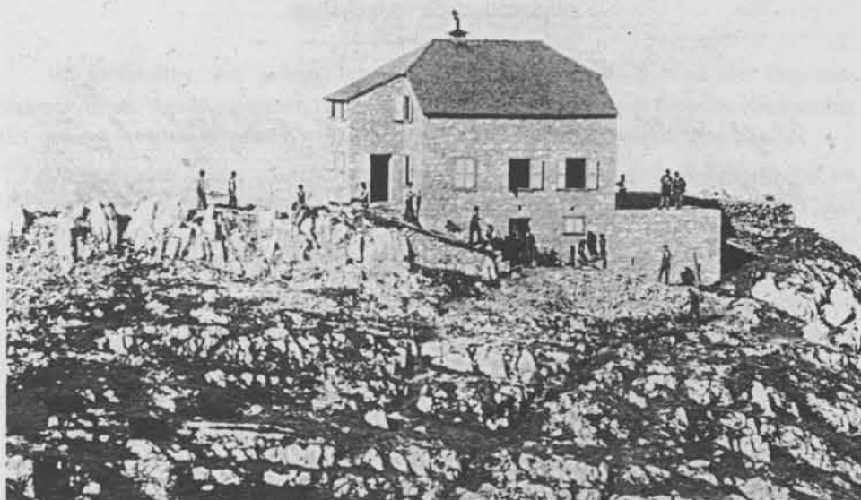
rege Bautätigkeit am Unterkunftshaus . . .
