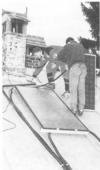
Montage der Solaranlage auf der Gumpertsbergerhütte
