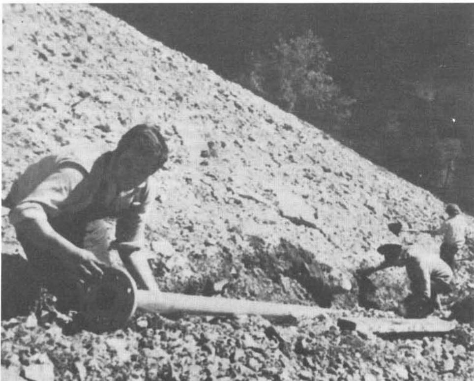
*Verlegen der Rohre für die neue Wasserleitung*
