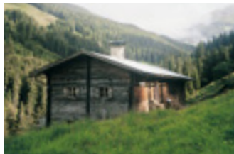
Weertalhütte, Akad. Sektion Innsbruck des ÖAV Ganzjährig zugängliche Selbstversorgerhütte mit 10 Schlafplätzen. Nähere Infos (Falblatt mit Anmeldebogen) in der Service-Stelle der Sektion München. www.weertalhuette.alpenverein.biz
