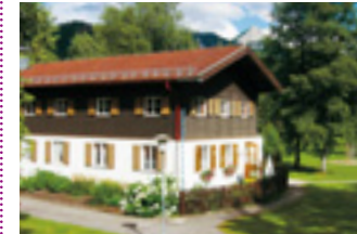
Haus Hammer, 750 m, Sektion München Talherberge in Fischbachau, Ortsteil Hammer (BOB-Haltestelle). Ganzjährig zugängliches Selbstversorgerhaus mit 58 Betten in 2-, 4- und 6-Bett-Zimmern und separatem Gruppenraum. Referent: Anton Hirschauer. www.haus-hammer.de
