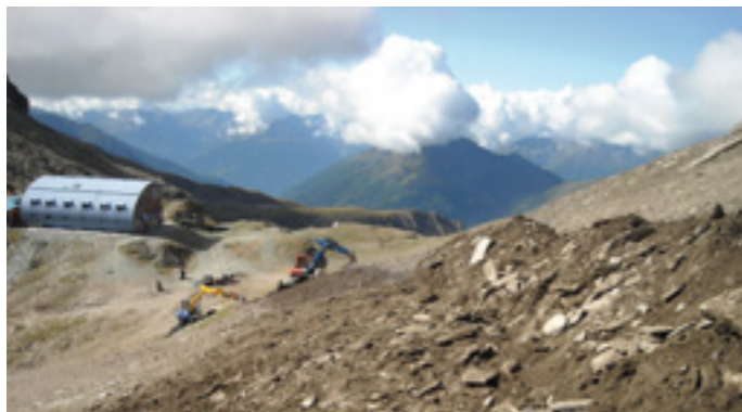
Bau der Wasserversorgungsanlage der Stüdlhütte
