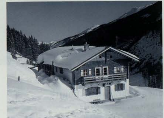
Die Alpschwendhütte an der Resterhöhe. Foto: K. Hörmann
