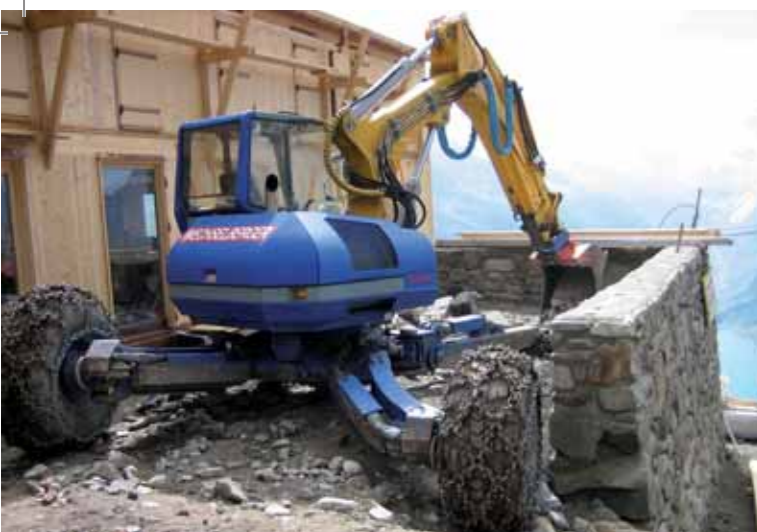
An sonnigen Tagen der unumschränkte „Star“ der Olpererhütte: Die Terrasse auf knapp 2400 Metern Höhe. Bis die Holzplanken verlegt werden konnten, ist viel Schweiß geflossen. Den Baggarbeiten folgte die Begradigung des Untergrunds, ehe das Metallgerüst befestigt werden konnte. Arbeit bereitet die Terrasse den Pächtern auch im Hochsommer – denn Schneeräumen ist auch im August angesagt.
