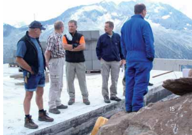
Lagebesprechung (v. l. n. r.): Willi Geisler, Polier; Henning Berkan, 1. Vorsitzender der Sektion Neumarkt i. d. OPf. des DAV e. V.; Peter Weber, Ressortleiter Hütten, Wege, Kletteranlagen des DAV; Ernst Pfeifer, Bauleiter; Hansjörg Wechselberger (von hinten), Stützmauer- und Wegebauer
