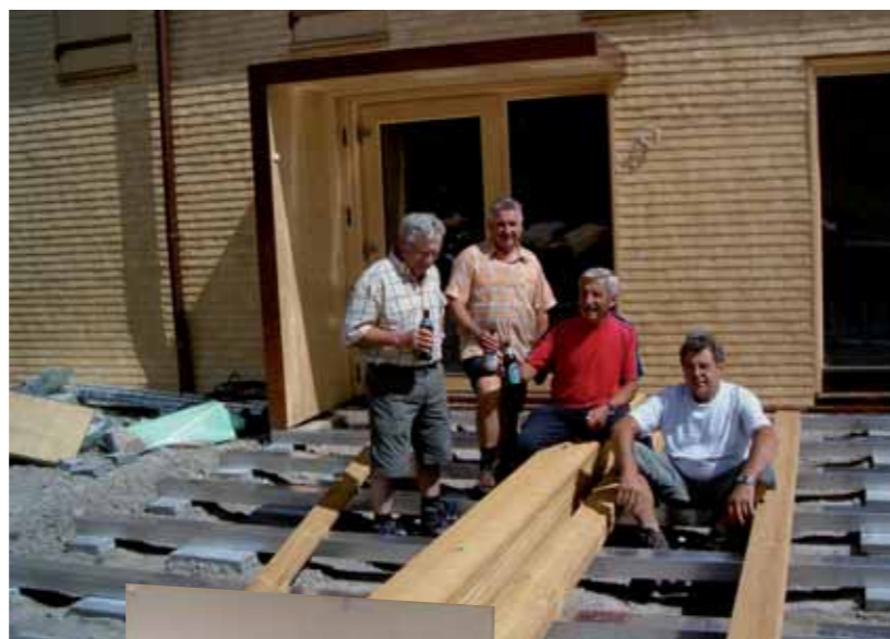
An sonnigen Tagen der unumschränkte „Star“ der Olpererhütte: Die Terrasse auf knapp 2400 Metern Höhe. Bis die Holzplanken verlegt werden konnten, ist viel Schweiß geflossen. Den Baggarbeiten folgte die Begradigung des Untergrunds, ehe das Metallgerüst befestigt werden konnte. Arbeit bereitet die Terrasse den Pächtern auch im Hochsommer – denn Schneeräumen ist auch im August angesagt.
