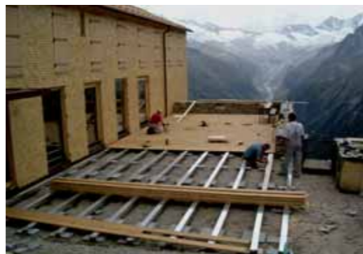
An sonnigen Tagen der unumschränkte „Star“ der Olpererhütte: Die Terrasse auf knapp 2400 Metern Höhe. Bis die Holzplanken verlegt werden konnten, ist viel Schweiß geflossen. Den Baggarbeiten folgte die Begradigung des Untergrunds, ehe das Metallgerüst befestigt werden konnte. Arbeit bereitet die Terrasse den Pächtern auch im Hochsommer – denn Schneeräumen ist auch im August angesagt.
