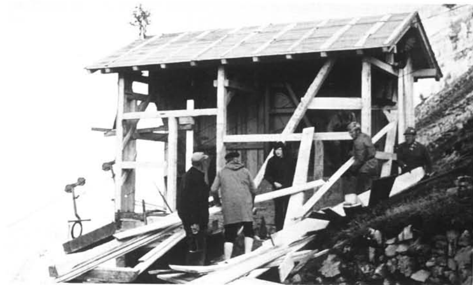
Der Bau der neuen Bergstation
