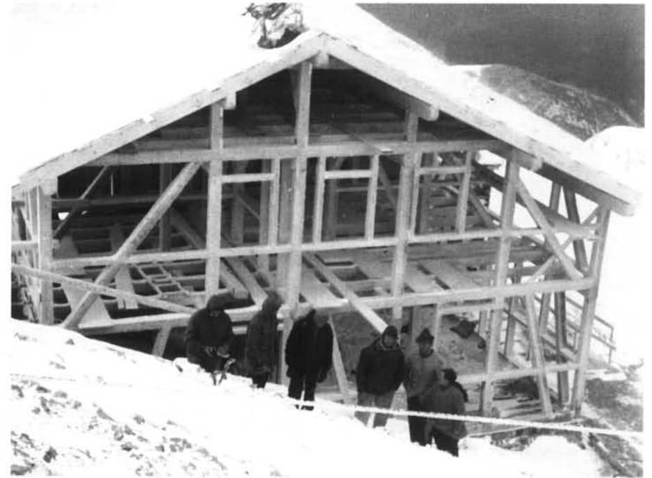
Das Fachwerk der Hütte ist errichtet
