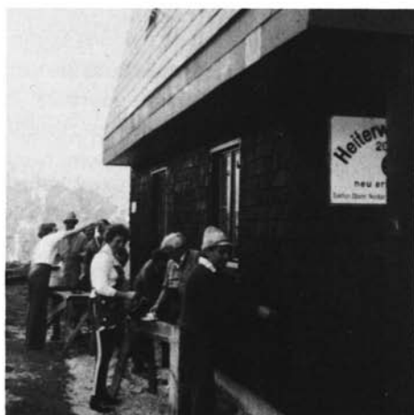
Das bewährte Handwerkerteam beim Anstreichen der neuen Hütte.
