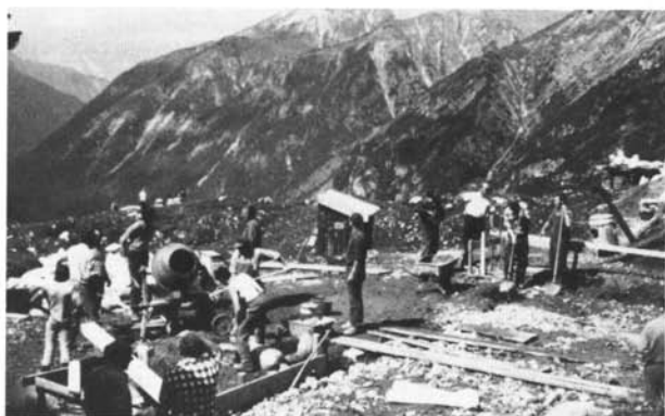
Die Betonkolonne beim Herstellen des Fundaments.
