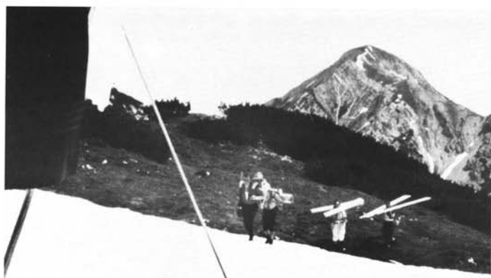
1967: Dacherneuerung der alten Heiterwand- hütte mit „Bergstei- gerkulis“.
