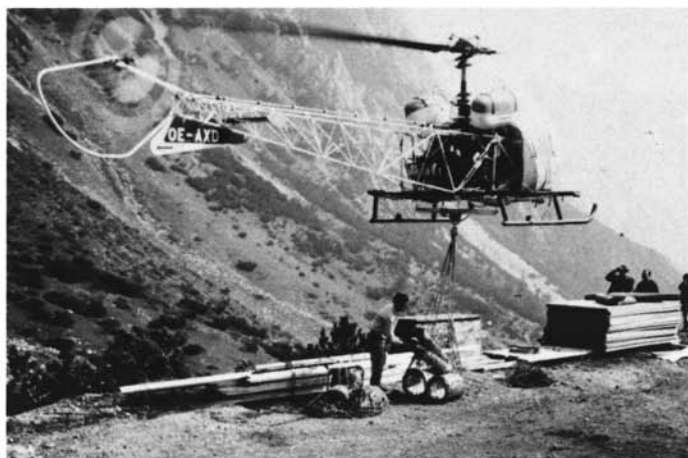
Der Hubschrauber bringt das auf dem Hahntennjoch gelagerte Baumaterial hinauf zur Baustelle.
