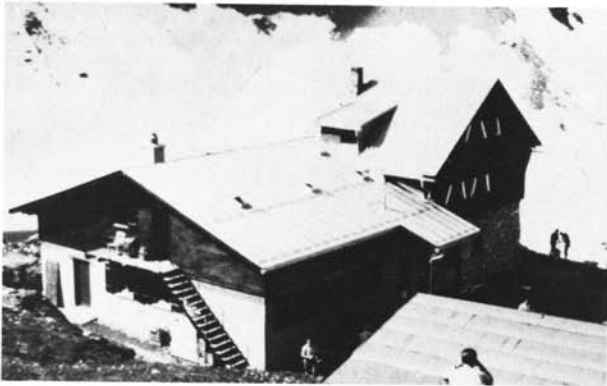
Der Anbau kurz vor der Fertigstellung.
