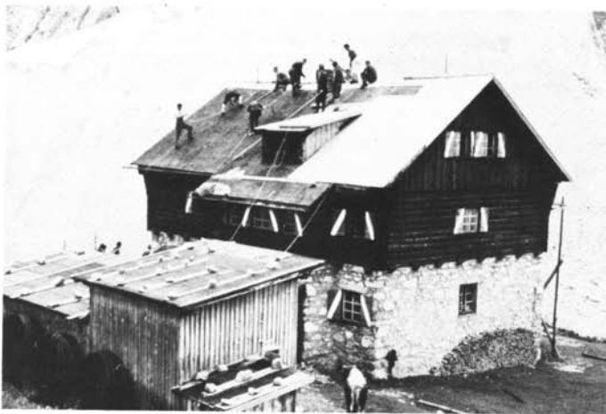
Auch das schadhafte Dach der Anhalter Hütte mußte erneuert werden. Viele freiwillige Helfer waren dabei eifrig am Werk.
