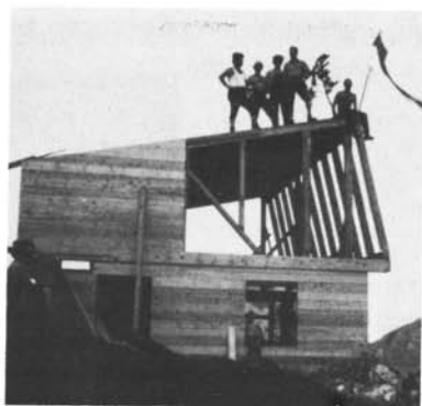
Auch ein Richtfest wurde gefeiert.
