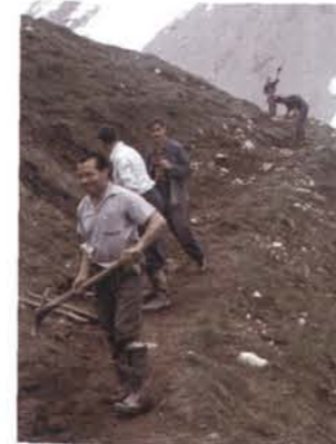
Bau der Wasserleitung
