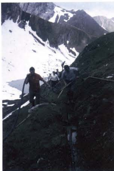
Eine neue Wasserleitung aus Kunststoff wird vom Tschachaun bis zur Hütte verlegt
