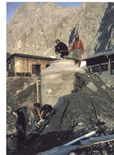
Bau eines Ausfallschachtes aus Betonfertigteilen
