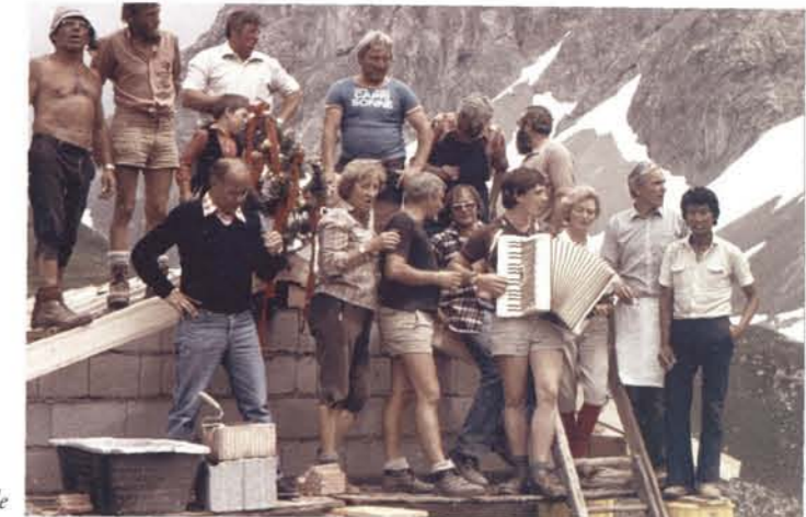
Richtfest beim neuen Aggregatsgebäude
