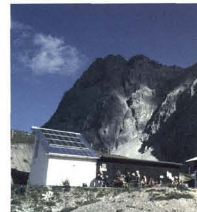
Das neue Technikgebäude und der Trockenraum – im Hintergrund die 2581 m hohe Gabelspitze
