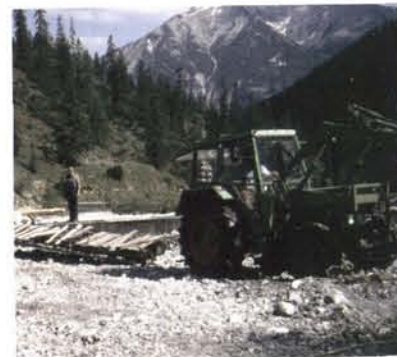
Manchmal können die erforderlichen Arbeiten nur mit Hilfe von Einheimischen und schwerem Gerät durchgeführt werden
