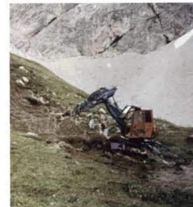
Zum Bau der neuen Quelfassung wurde auch ein Bagger eingesetzt
