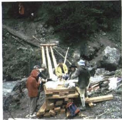
Der Brückenbau in diesem Gelände erfordert einen hohen körperlichen Einsatz
