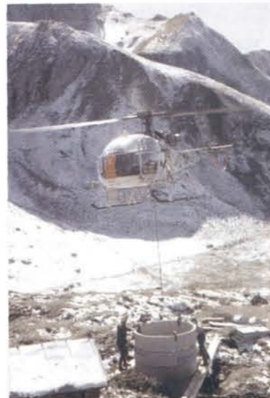
Arbeiten an der Kläranlage der Anhalter Hütte
