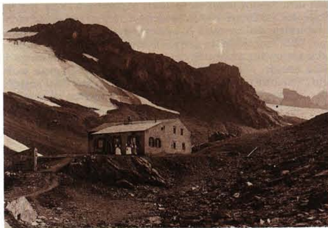
Die Stüdlhütte nach dem Anbau 1903
