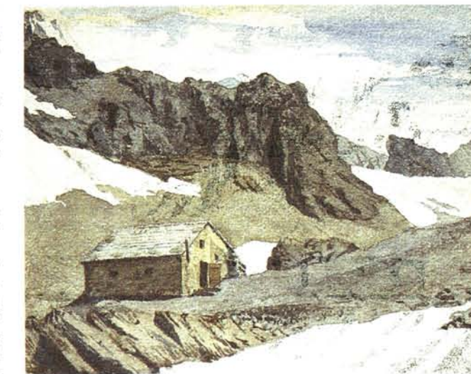
Stüdlhütte im Bauzustand nach 1873
