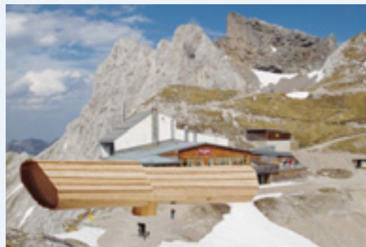
Das futuristische „Fernrohr“ des im Bau befindlichen Naturinfozentrums
