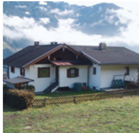
Pension „Kashütte“ (Hippach, Zillertal) vor dem Umbau
