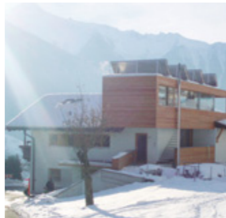
„Kashütte“ nach dem Umbau
