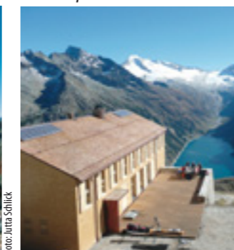
Die neue Olpererhütte im Bau
