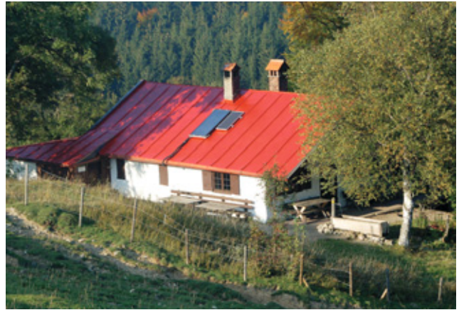
Die Gumpertsbergerhütte, eine von 25 Selbstversorgerhütten der Sektionen München & Oberland
