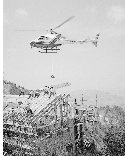
Neubau des Dachgeschosses am »Staufner Haus«
