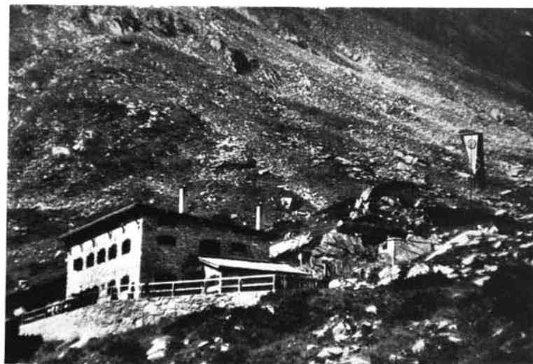
Die Osnabrücker Hütte während der Fünfzigjahrfeier.
