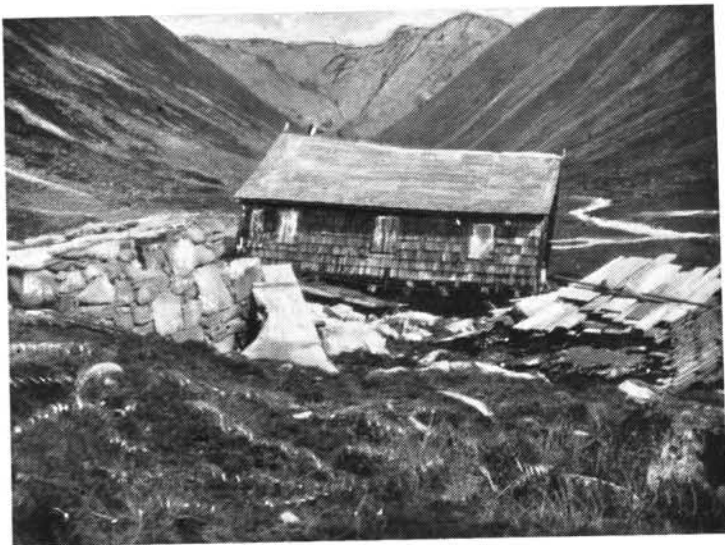
Die Februar 1929 durch Lawinendruck zerstörte Osnabrücker Hütte.
