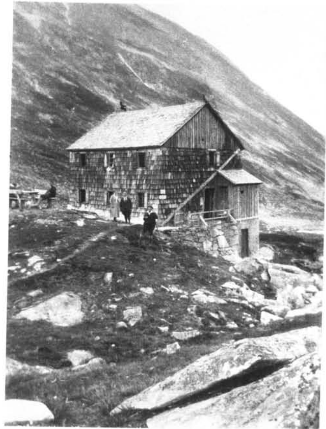
Die Osnabrücker Hütte im September 1926.
