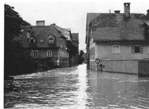
10. Juli 1954 – Hochwasser in Passau.
