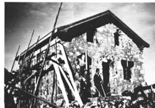
Wiederaufbau der Passauer Hütte Okt./Nov. 1954.
