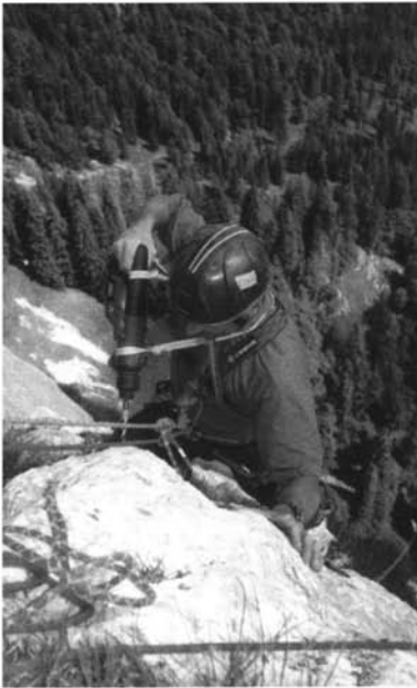
Beim Routensanieren in der Geißelstein Ostwand
