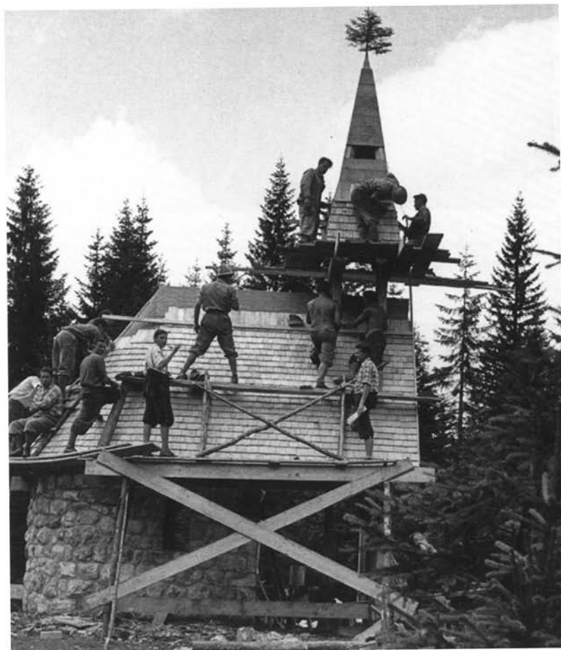
Dachdeckung und Hebauf
