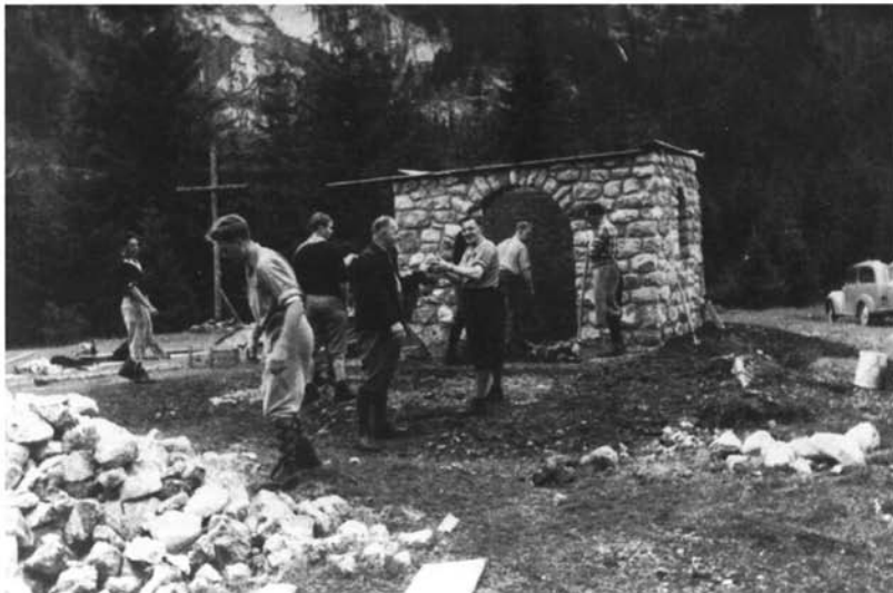
Kapellenraum im Rohbau
