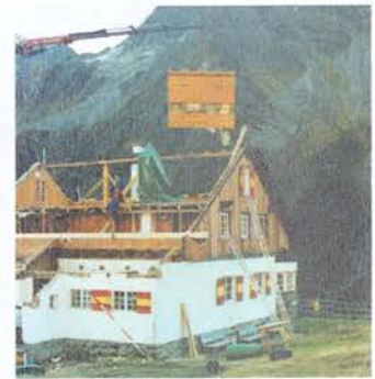
Bild oben: Im Tal vorinstallierte Bauteile werden mit dem Kran an die richtige Stelle gestellt.
