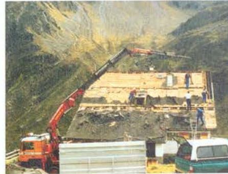
Bild oben: Im Tal vorinstallierte Bauteile werden mit dem Kran an die richtige Stelle gestellt.
