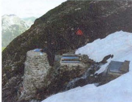
Waldberger Haus: Trinkwasserfassung mit Abwasserbehälter
