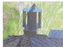
Waldberger Haus: Kleinwindkraftanlage zur Vorsorgung der Abwasser- reinigung
