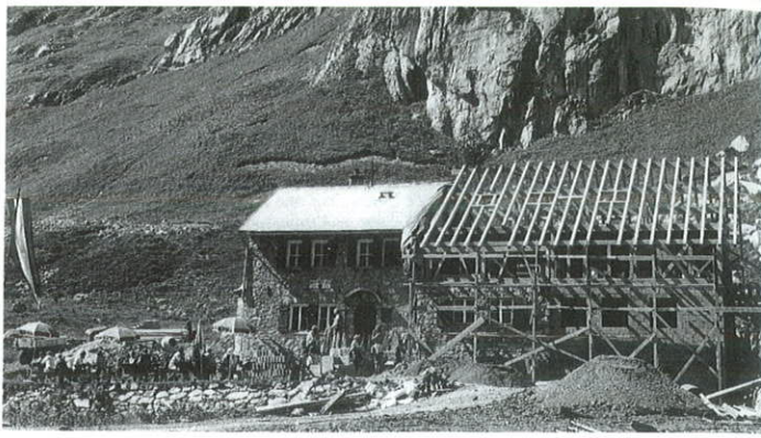
Errichtung des Rohbaus (Foto von Necker)
