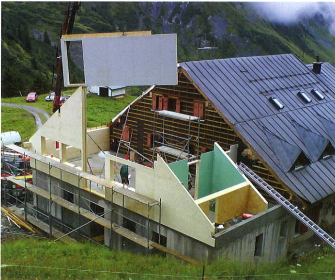
Der neue Anbau wird erstellt
