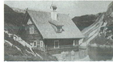
Ditteshütte am Spullersee
