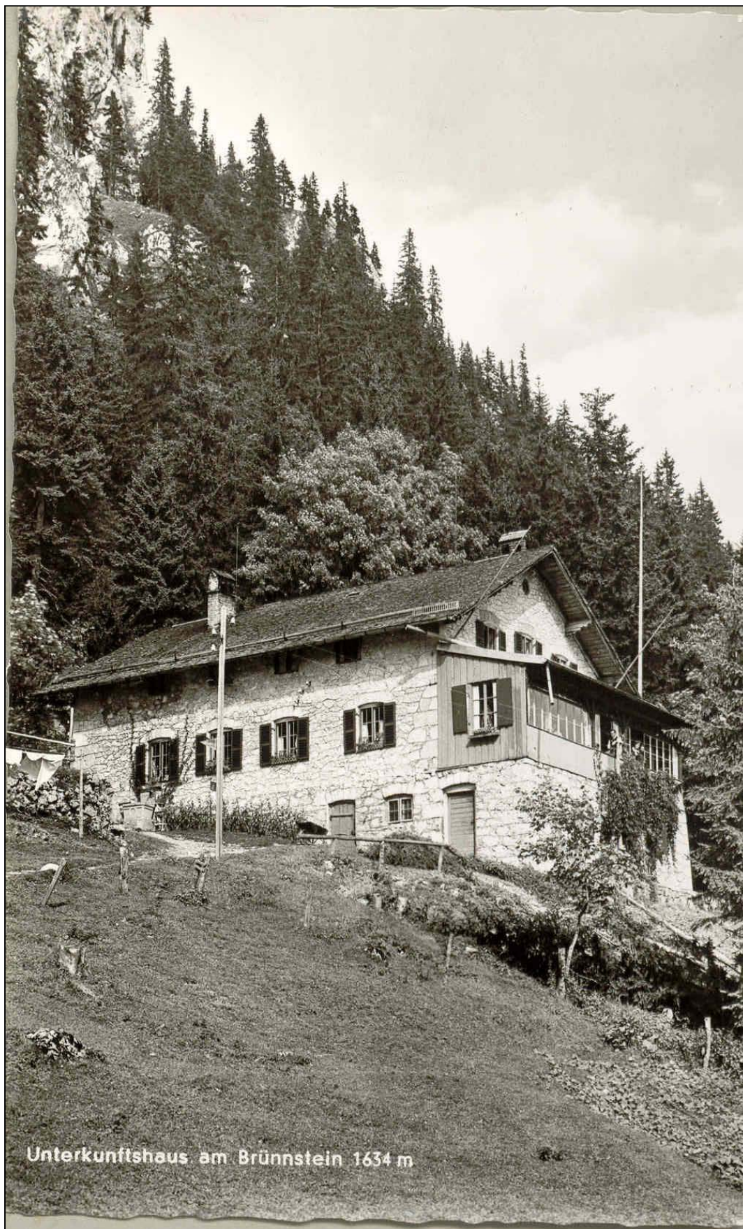
Das Brünsteinhaus vor den Anbau- und Umbaumaßnahmen
