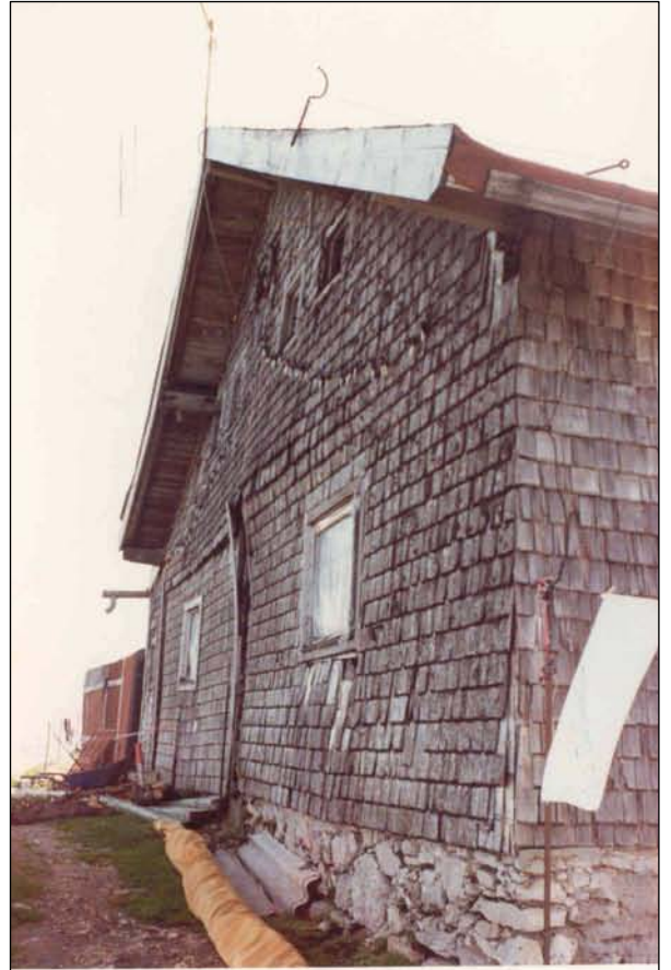
Baubesprechung auf dem Hochriesgipfel
