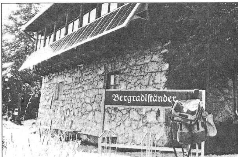
Am Salettl werden die Sonnenstrahlen für die Stromversorgung eingefangen.
